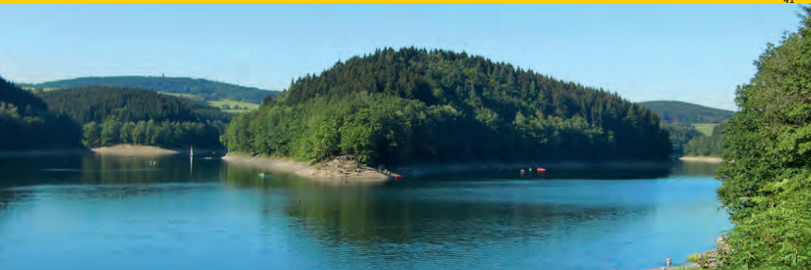
Foto oben: Aggertalsperre
